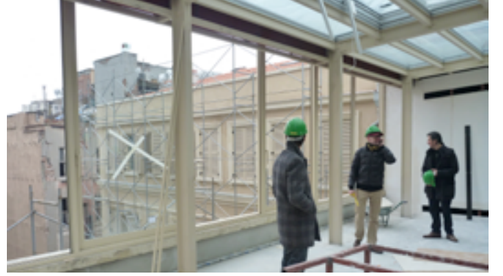
SALT Beyoğlu bahçesi inşaat halindeyken
