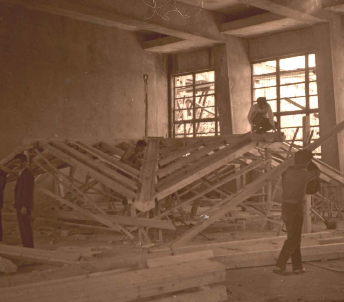
Marangozhanede çatı üretilirken, tahminen 1963
