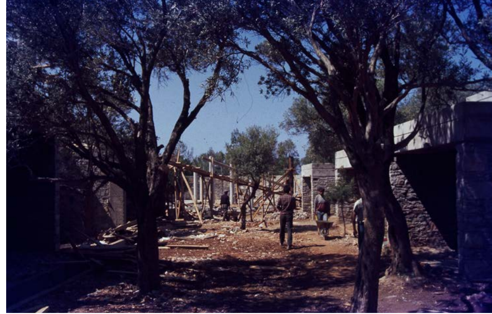
Kulüp Ora Tatil Köyü inşaatı, tahminen 1990, Muğla
