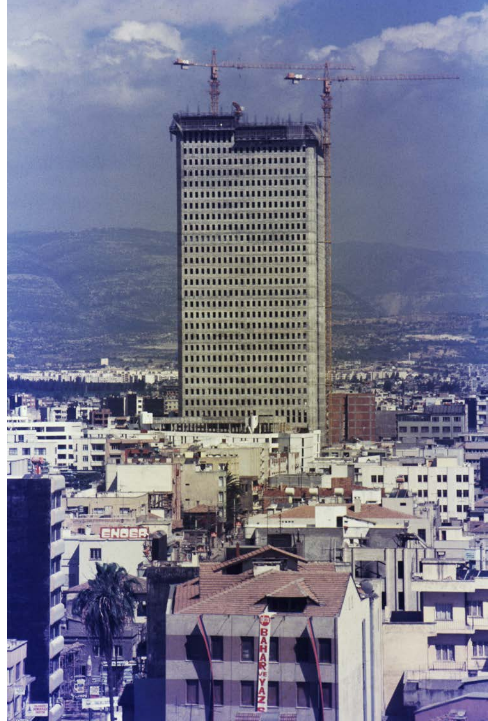
Mersin Kompleksi inşaatı, tahminen 1980’ler ortası
